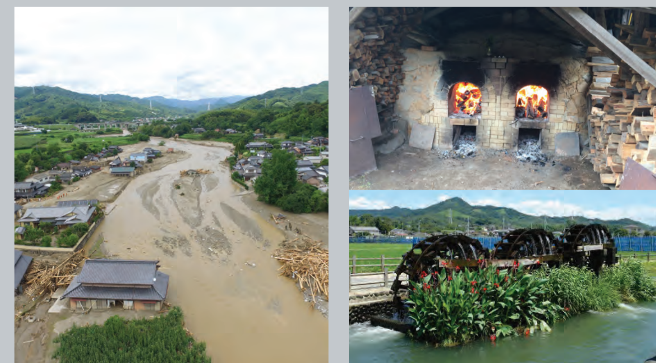
平成29年7月九州北部豪雨で被災した朝倉地域の様子
